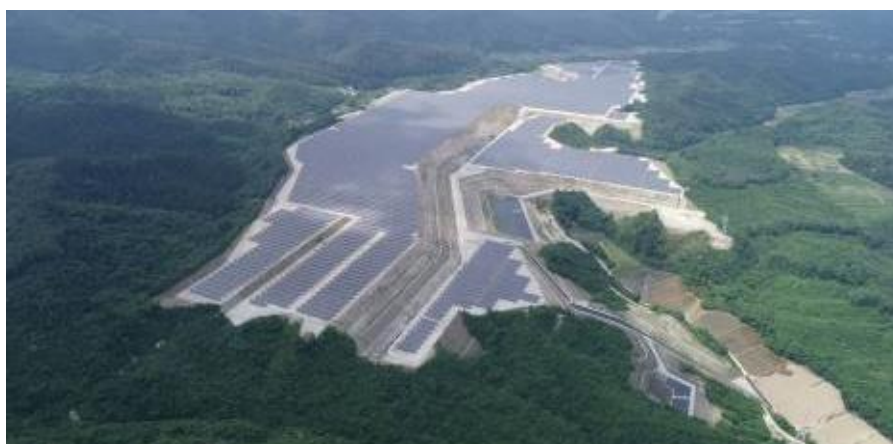
Une usine d'énergie solaire de 28 MW dans la préfecture de Miyagi
