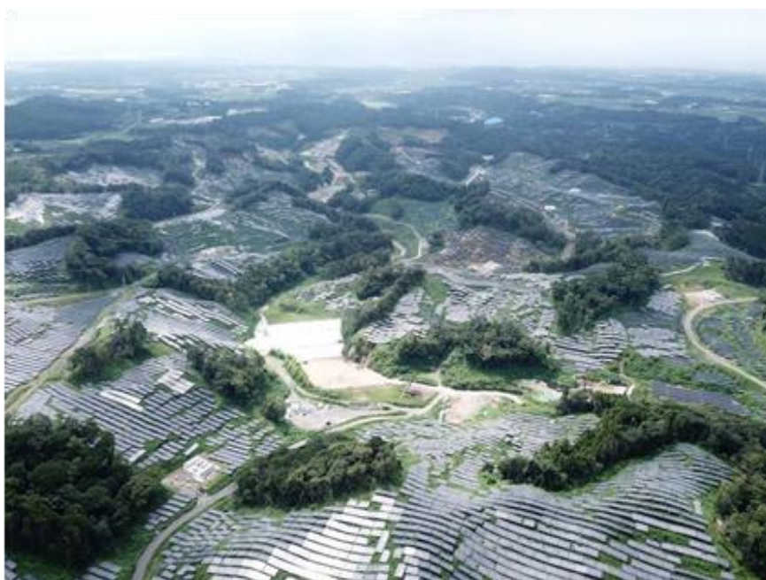
Usine d'énergie solaire de Kanoya Osaki Solar Hills
