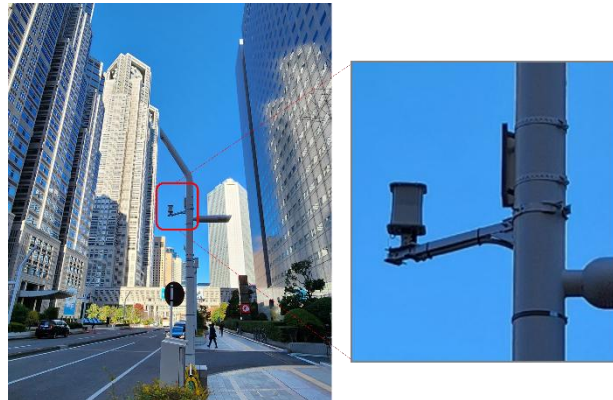
Installation d'un répéteur dans la région de Nishi-Shinjuku (Tokyo, Japon)
